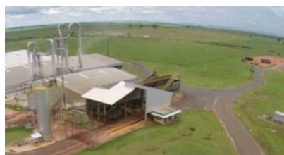
キャッサバ澱粉工場
