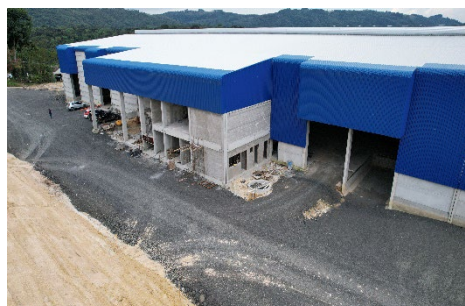
Fábrica de erva-mate em fase final de construção.
